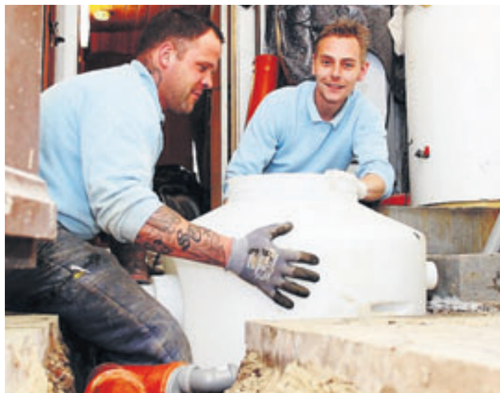
Philipp Corßen (rechts) baut mit seinem Mitarbeiter Peter Maack einen Unterflurbehälter für eine Pumpenanlage in Findorff ein. Foto:TOB
