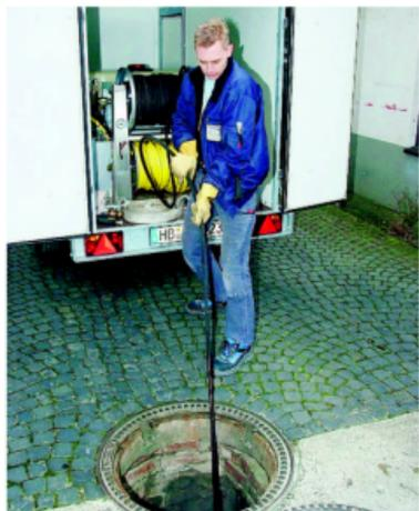
Mit eigenem Wassertank lassen sich die Kanäle und Rohrleitungen überall freispielen und kontrollieren. Foto: FR
