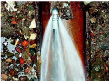
Mit starkem Druck spült der Spezialkopf die Rohre frei, damit die Kamera freie Sicht auf das Material hat. Foto: FR
